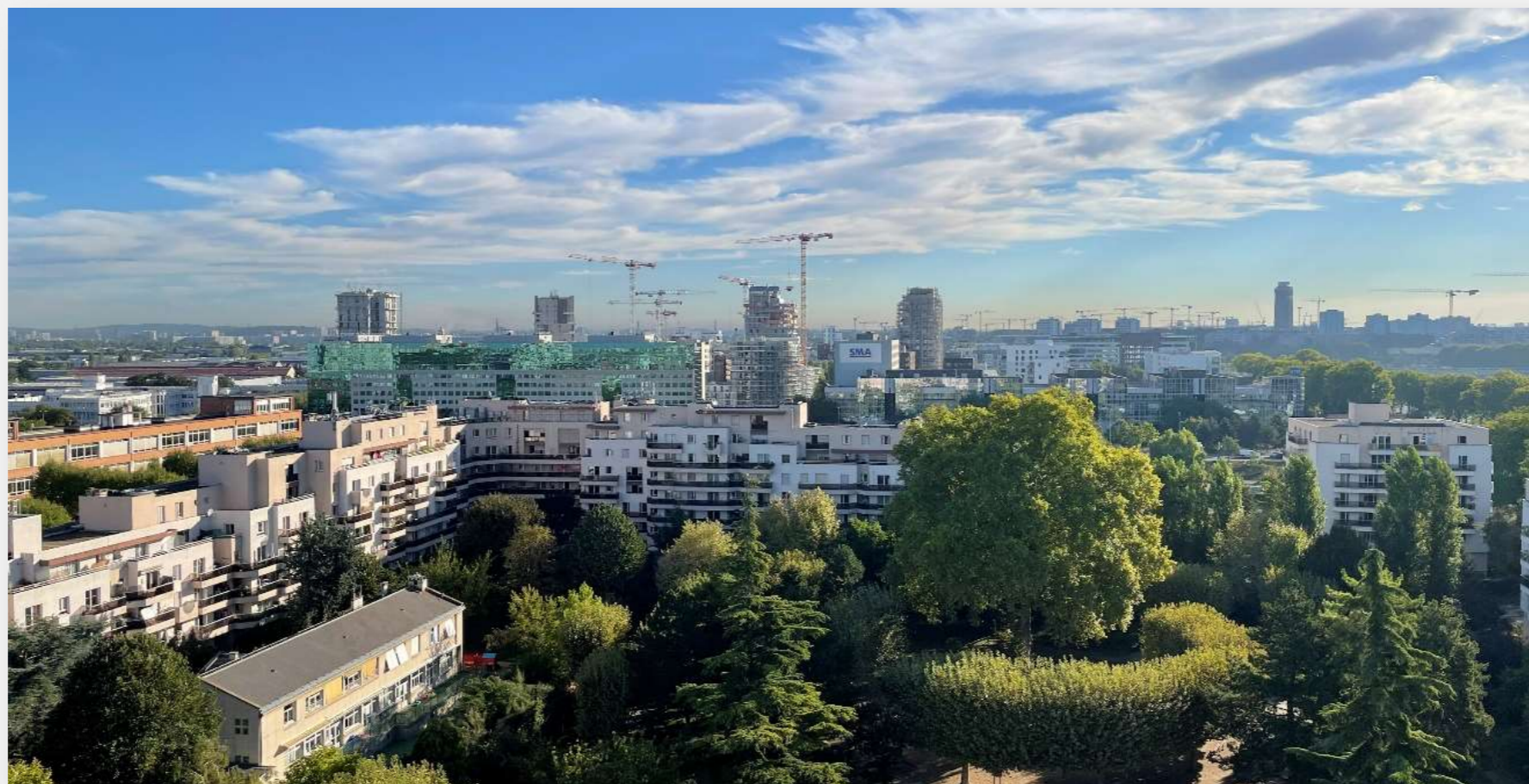
Vue panoramique depuis ASNIERES-SUR-SEINE sur les chantiers en cours à GENNEVILLIERS (situés devant le site du projet objet du présent dossier) et les nouvelles constructions sur L'ILE-SAINT-DENIS (à droite)
