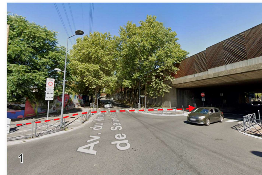
Traversée (depuis le sud) du le passage protégé avenue du Vieux chemin de Saint-Denis avant le passage sous le viaduc de l'A86
