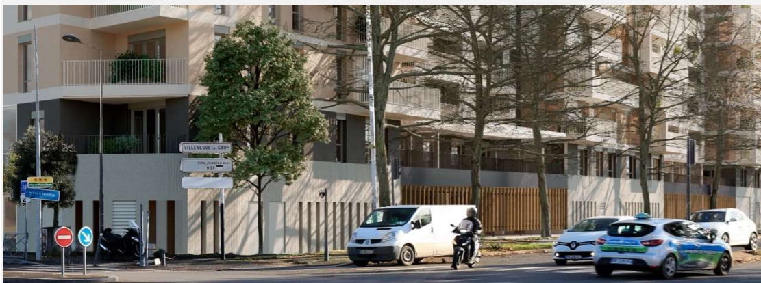
Barreaudage à claire-voie du socle des bâtiments L1 et L3 laissent passer la crue
