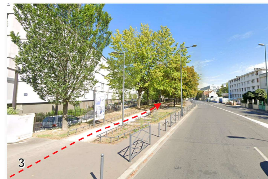
Cheminement piéton le long du boulevard Gallieni en direction du centre-ville après la traversée du protégé aménagé sur la rue Nelson Mandela
