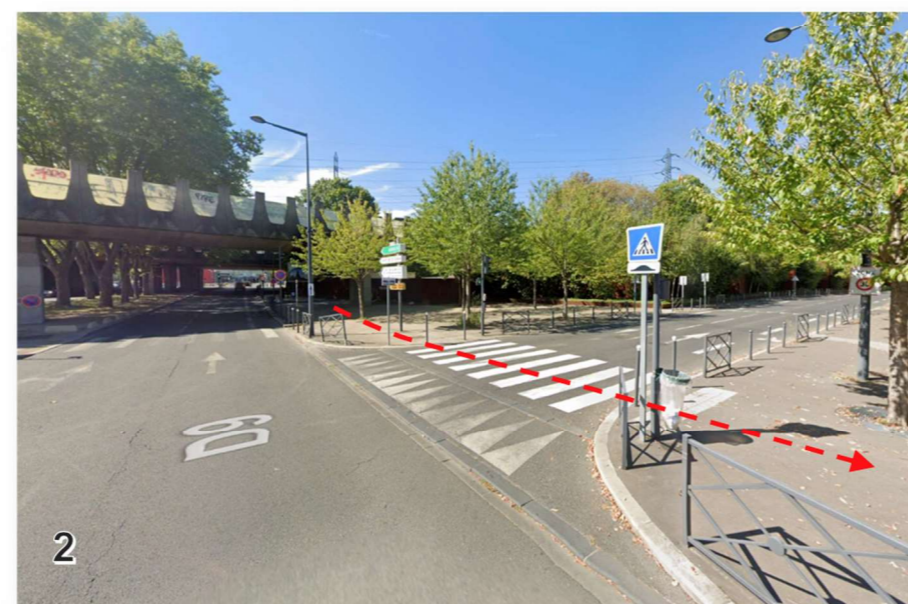
Traversée du passage protégé aménagé sur la rue Nelson Mandela après le passage sous le viaduc de la bretelle d'accès à l'A86
