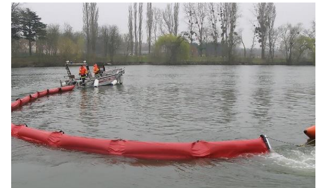
Mise en place d'un barrage flottant
